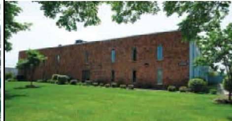
12950 HAGGERTY VAN BUREN TOWNSHIP
