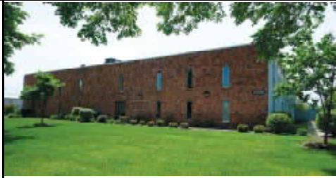
12950 HAGGERTY VAN BUREN TOWNSHIP
