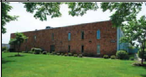
12950 HAGGERTY VAN BUREN TOWNSHIP
